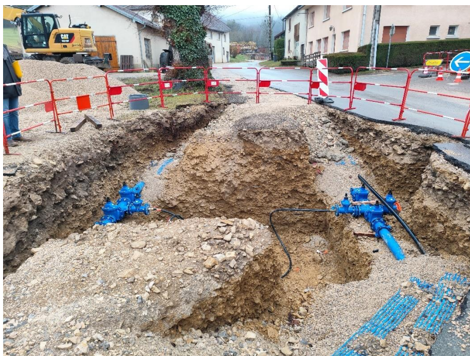
Chantier : renouvellement du réseau d'eau potable – Rue Montravers (2025)
