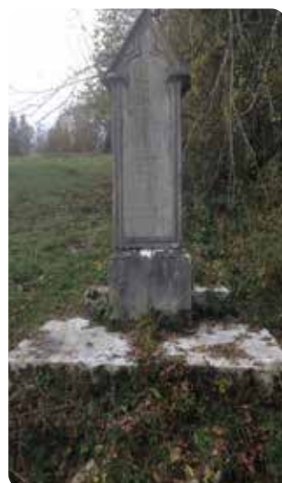
Stèle avant les travaux
