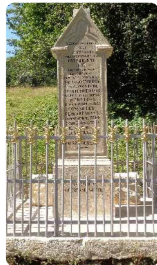
Stèle après les travaux
