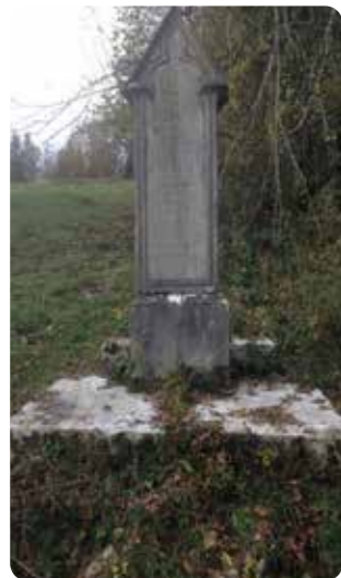
Stèle avant les travaux
